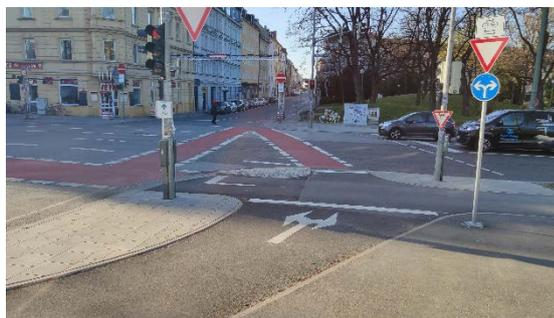
Zustand **nachher** mit rot markierten Radwegfurten und geänderter Radwegführung
